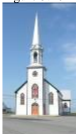
Figure 5.46 L'église et le presbytère de Saint-Maurice
