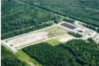
Figure 3.30 Le lieu d'enfouissement technique (L.E.T.)
