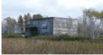
Figure 5.60 Vestiges de l'Engine Room
